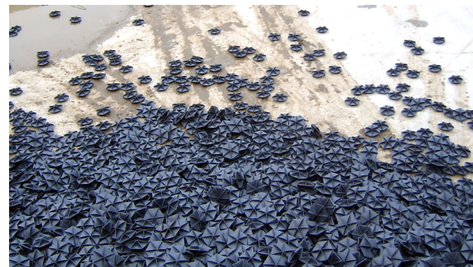
Hexa-Cover® plávajúce prekrytie Inštalácia aj do prázdnych nádrží (hĺbka max. 5m)
