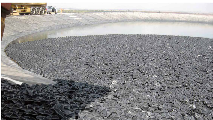
Hexa-Cover® plávajúce prekrytie Dodávka ako sypaný materiál a inštalácia:
